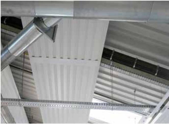
Die Wärmestrahlung erwärmt nicht die Luft, sondern alles, was sich in der Halle befindet – Menschen, Maschinen, Material und den Fußboden.
